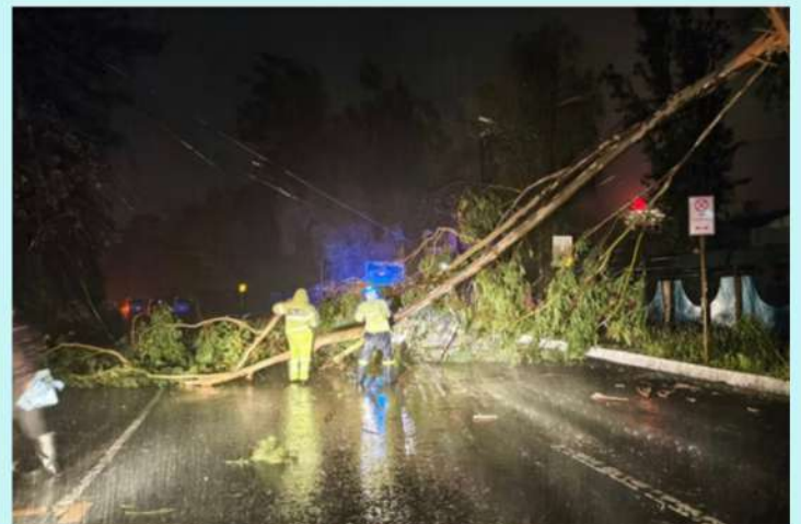
▲倒木被害の復旧の様子
